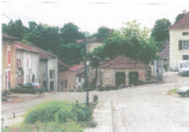
Le centre du village avec son bâti serré et ses rues étroites et en pente.
