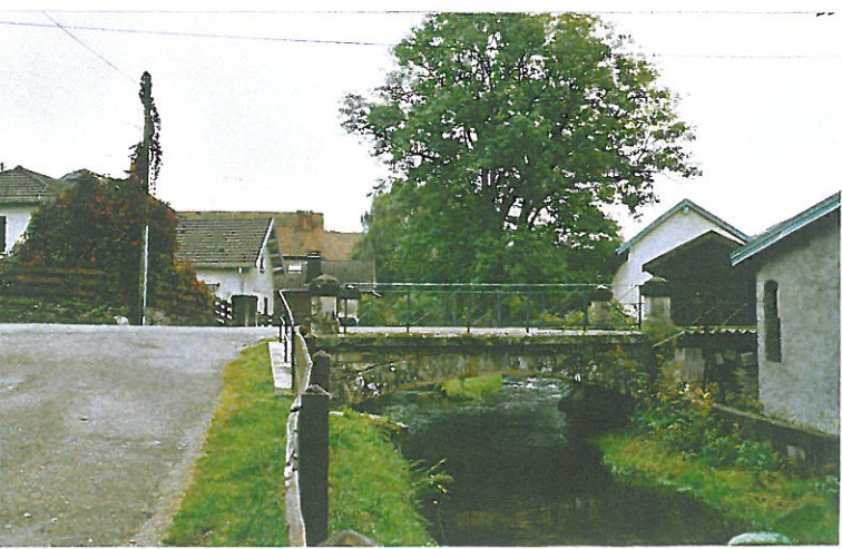
APRES Pont sur le ruisseau d'Argent
