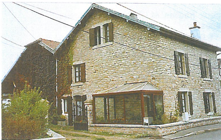
Bel exemple de réhabilitation (toiture en tuile, menuiseries en bois).
