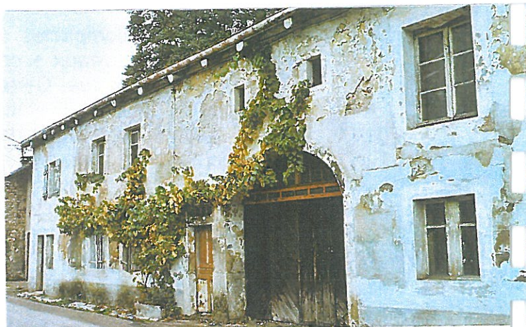
Bâti ancien à rénover. Présence de porte charretière et vigne, éléments témoins de la tradition lorraine.
