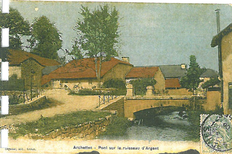
AVANT Pont sur le ruisseau d'Argent
