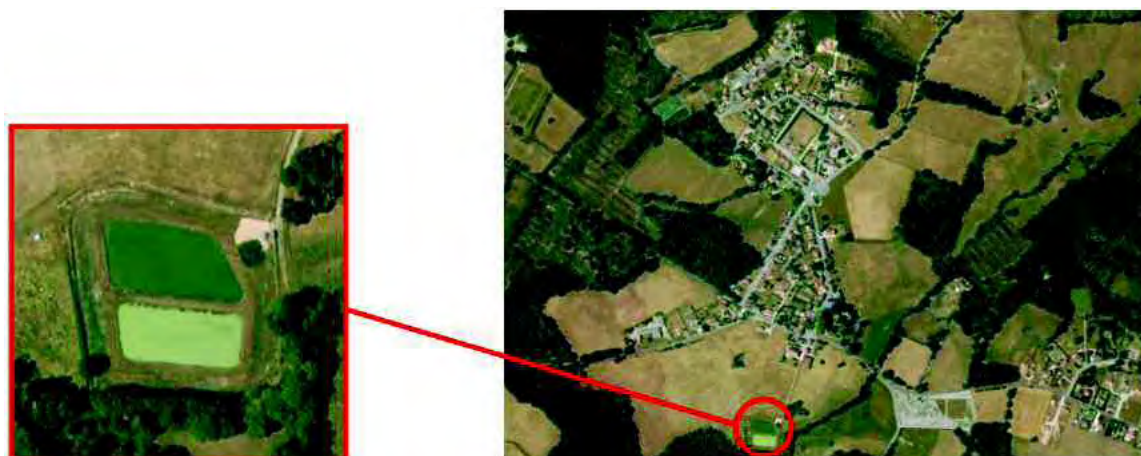
Figure 42 : localisation de la station d'épuration du bourg de Veyrac – station 2, Le Pennaux
