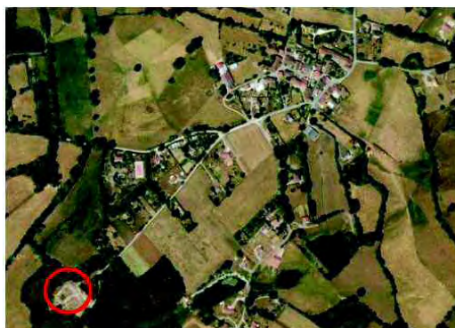
Figure 43 : localisation de la station d'épuration de la Grange de Bœuil
