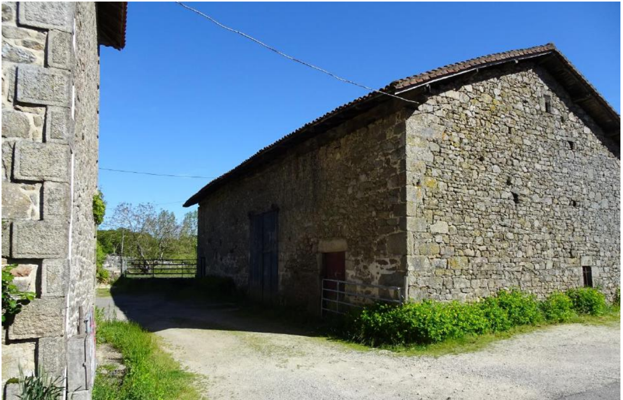
Photo : Bâtiment concerné
