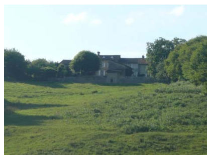
28. La Chaise : alignement bâti
