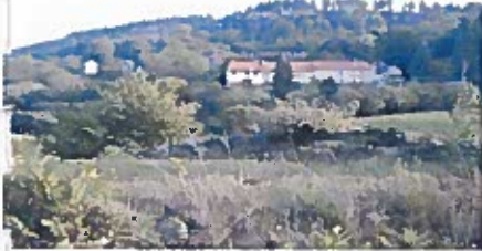
Restauration à Mallety...
