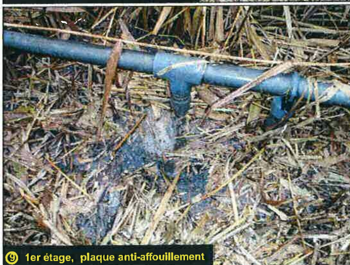
Répartiteur 2 vannes du 1er étage
