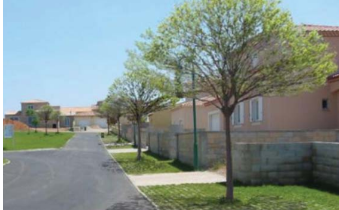
Stationnement latéraux aménagés sur des surfaces perméables
