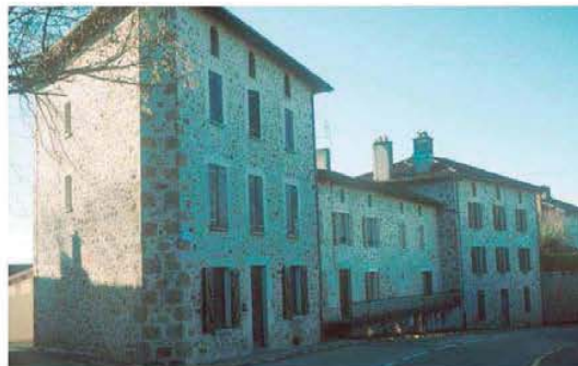
À Rochechouart (Haute-Vienne), l'habitat constitué de toitures de tuiles et de murs enduits à pierre vue
