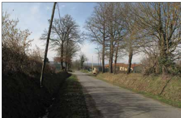
La route des Goupillères. A droite, l'habitat pavillonnaire en limite du site. Les eaux pluviales sont gérées par des noues.
