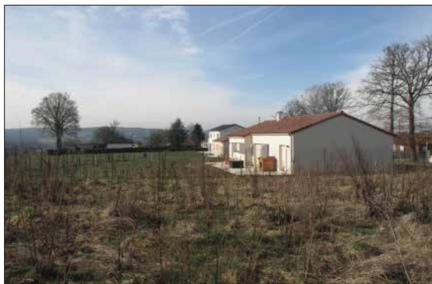
Des nouvelles constructions de type pavillonnaire, en limite Ouest du site
