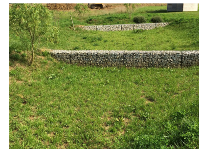
Exemples de traitement des eaux pluviales (source : CAUE 54) avec de haut en bas : avec noue paysagère et gestion différenciée de la végétation ; ralentissement du ruissellement par création de petits seuil ; noue paysagère.
