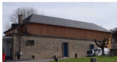
Intégration réussie de l'isolation par l'extérieur et bardage bois du cinéma (Peyrat)
