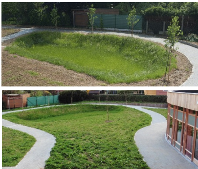
Exemple de gestion des eaux pluviales sur la parcelle (Source : MATRICIEL & Bernard Boccara) : tranchées de rétention et d'infiltration
