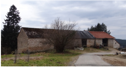
Exemples de bâtiments agricoles bien implantés en tenant compte de la topographie (Peyrat)
