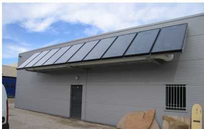
Exemple de chauffage d'un bâtiment grâce à des capteurs solaires à air (source : e2-solaire.com)
