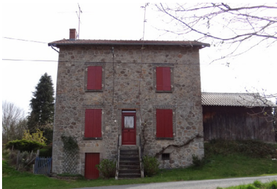
Exemple de construction qui s'intègre bien en zone agricole : volume simple, menuiserie et encadrements soignés, grange attenante, implantation proche de la route (Peyrat)
