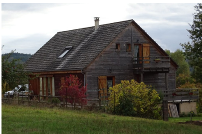
Exemple de maison d'habitation récente adaptée dans le paysage rural (Peyrat) : forme simple et massive, façades et toiture en bois grisant naturellement, toiture 2 pans...
