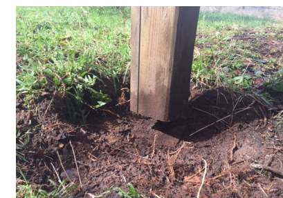
Exemple de structure sur pilotis autorisée en secteur Nt (Peyrat)
