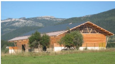
Exemple de bâtiment industriel avec toiture photovoltaïque : négoce de matériaux (source : prix national de la construction bois)
