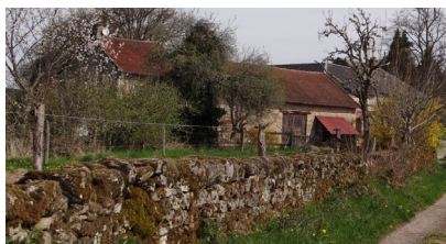
Exemple de muret à conserver (Peyrat)
