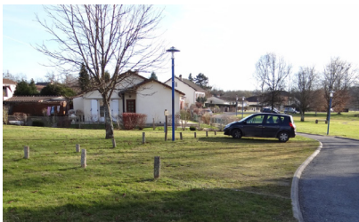
Exemple d'aire de stationnement perméable (Chamborêt, 87)
