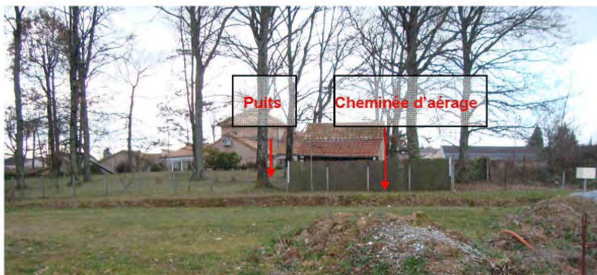
Photo 2 : Maison d'habitation située impasse depuis la rue Camille concernée par l'aléa « effondrement localisé » de niveau faible à moyen ainsi que par les ouvrages débochant au jour
