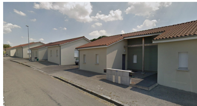
5. Maisons de l'ODHAc le long de la rue de la Renaissance
