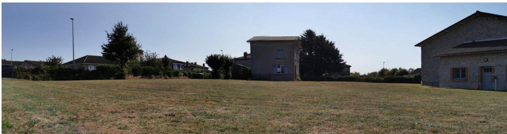
9. Vue depuis l'intérieur du site sur la partie nord-est de celui-ci avec la salle des associations à droite et la maison existante au centre
