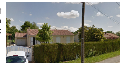
Maisons au sud du site
