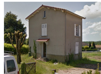
8. Maison existante sur l'OAP depuis la rue des Hortilliers
