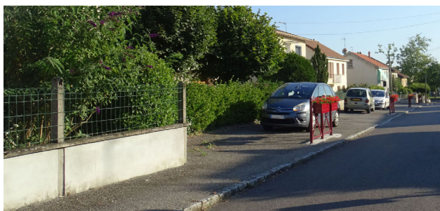
Exemples de clôtures adaptées avec de haut en bas : clôture végétale doublée par un grillage sur l'arrière, muret bas surmonté d'un grillage, grillage doublé de végétaux à l'intérieur
