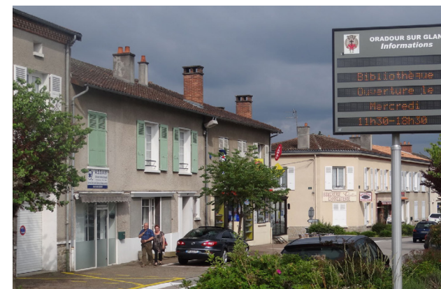
Secteur centre ville : mur gouttereau sur rue, enduit de façade plein, volets battants en bois, toiture en tuile ronde ou canal, cheminée en brique ou ciment et mitron...
