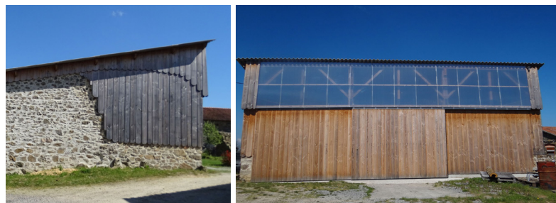
Rénovation d'un ancien bâtiment : bardage en bois, décroché et décors de façade
