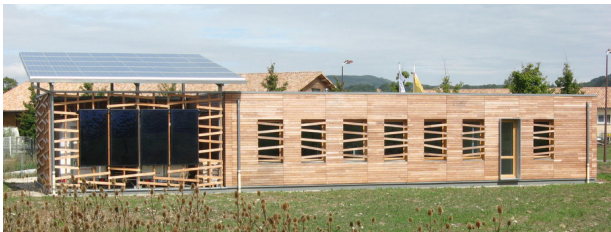
Intégration des panneaux solaires dans la composition générale du bâtiment à Eurre (26) - Source : http://www.prixnational-boisconstruction.org
