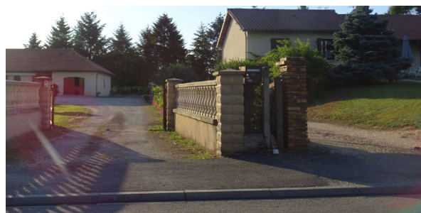
Exemples de revêtement de sol perméable : chemins d'accès en gravillons
