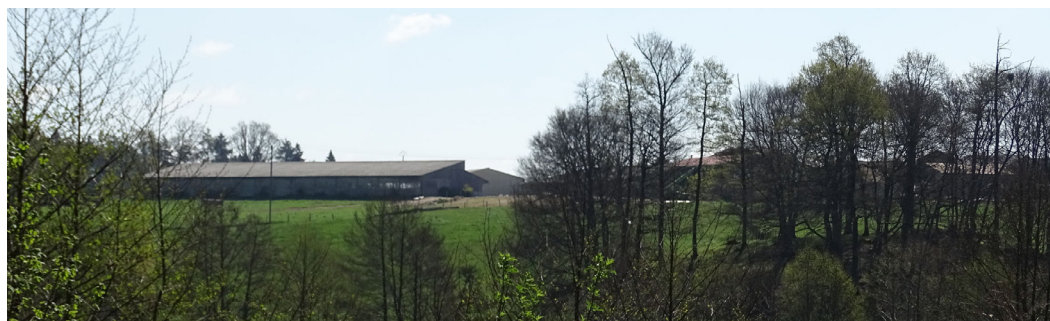
Bardage et toiture sombre, proximité des autres bâtiments de la ferme
