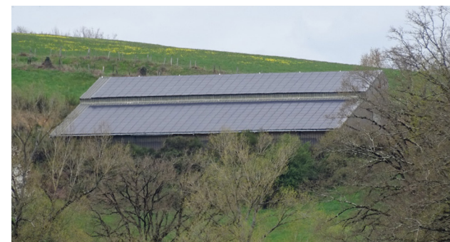
Panneaux solaires sur un bâtiment actuel (St-Etienne de Mours, 15)
