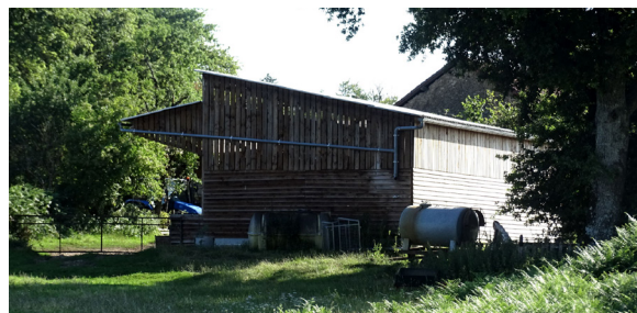
Décroché de toiture et pentes dissymétrique 1 pour 1/4..., jeu dans l'agencement horizontal et vertical du bardage en bois laissé brut, dimensions modestes, gouttières inox... l'ensemble à l'appui d'un boisement et à proximité des autres bâtiments de la ferme
