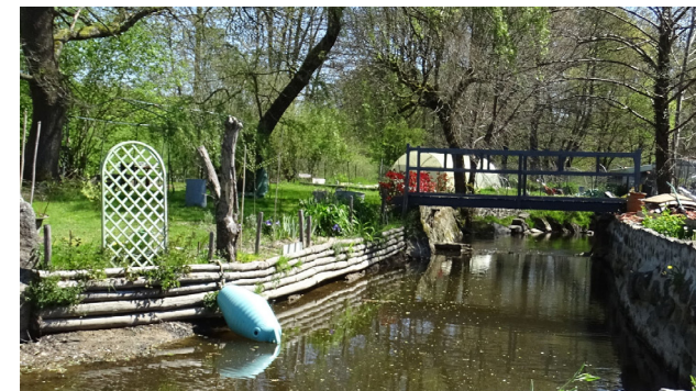
Exemple d'aménagement léger pour la mise en valeur des espaces naturels : petits rondins pour retenir les berges, pont piéton...
