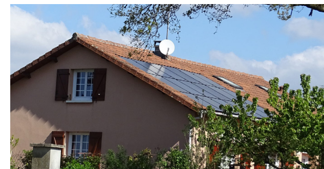
Bonne intégration des panneaux solaires : rassemblés plutôt en bas de toiture, intégrés dans l'épaisseur de la toiture, panneau sombre et encadrement sombre.
