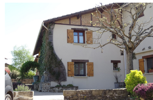
Rénovation remarquable mêlant harmonieusement éléments traditionnels (enduit, brique, colombage) et décors d'inspiration contemporaine (angle de la façade)
