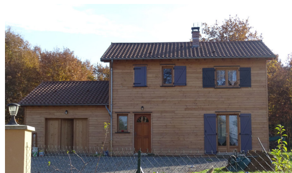
Forme massive sur 2 niveaux, bardage bois naturel, volets sombres, tuile rouge sombre
