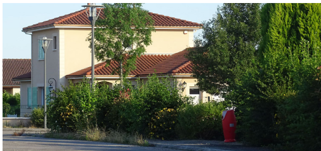
Extension traitée en harmonie avec la façade sur laquelle elle se greffe : prolongement du pan de toiture, enduit de la couleur du jointoiment voisin
