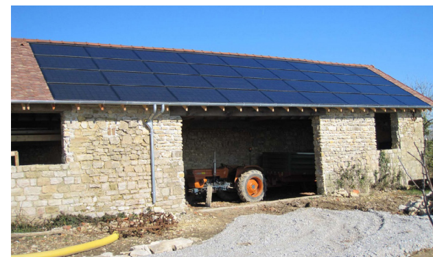
Panneaux solaires sur une vieille grange où les cadres noirs facilitent l'intégration sur la toiture (source : www.solesens.fr)
