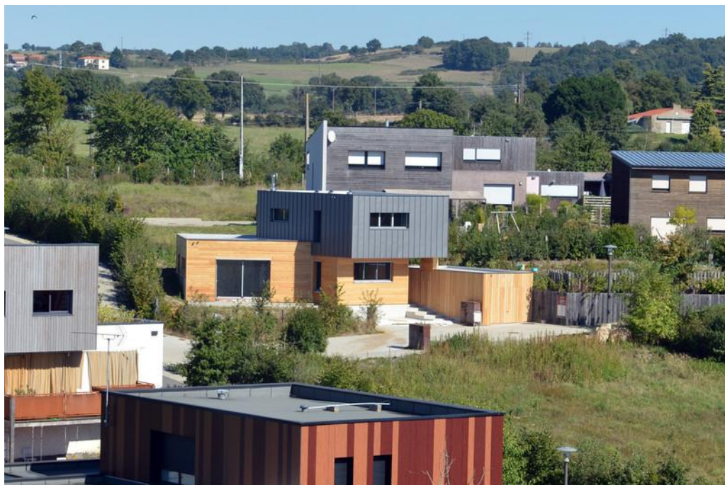
Eco-quartier du Val de la Pellinière aux Herbiers (85) : maisons sur plusieurs niveaux pour s'adapter à la pente du terrain (source : http://www.prixnational-boisconstruction.org )
