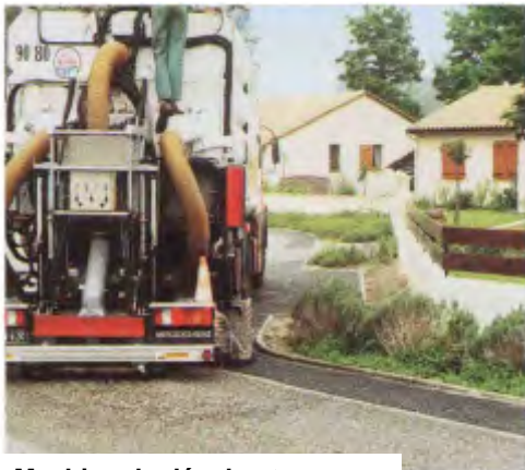
Machine de décolmatage. Source CETE du Sud-Ouest
