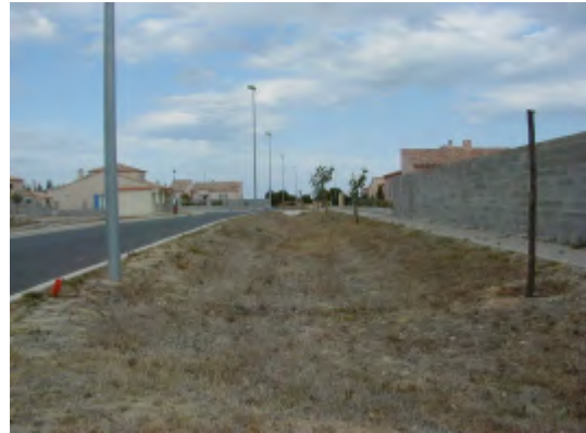
Noue en construction à Alénia Lotissement « les Vignes » Source DDE 66
