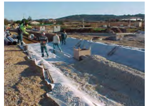
Préparation de la structure-réservoir à St Mathieu de Trévières (34) Source DDE 34
