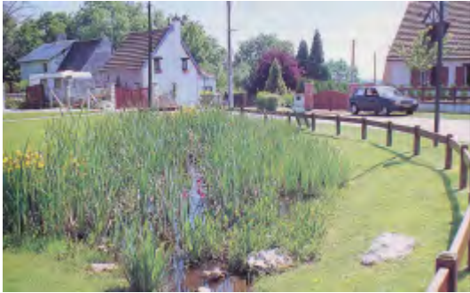
Noue engazonnée Opération Belbeuf – 76 Source Foncier Conseil
