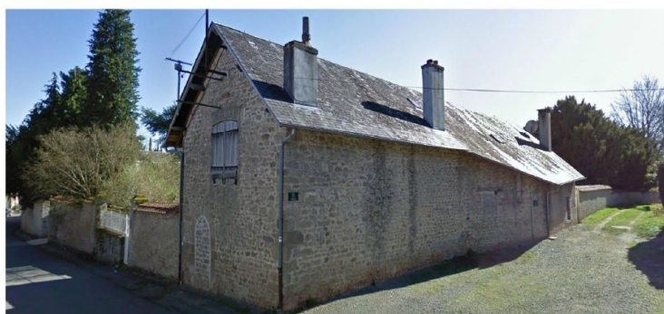
07 - Bourg - Ancien logis / 17 - Mur d'enceinte
