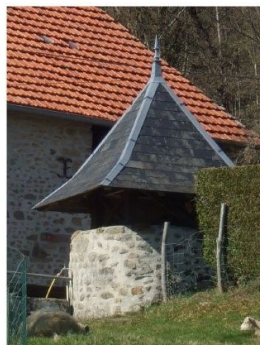
04 - Puits - Les Adoux
