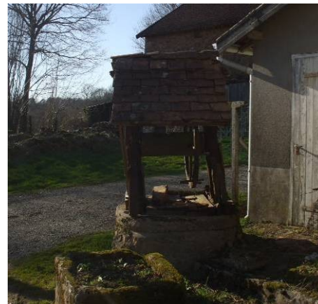
Puits à margelle et abri au hameau Les Petits Marmiers.
