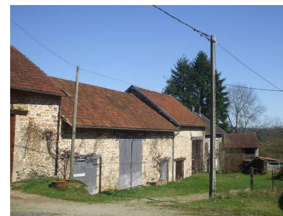
Granges-étables et logis de ferme accolés, décrochement du niveau de toiture.
