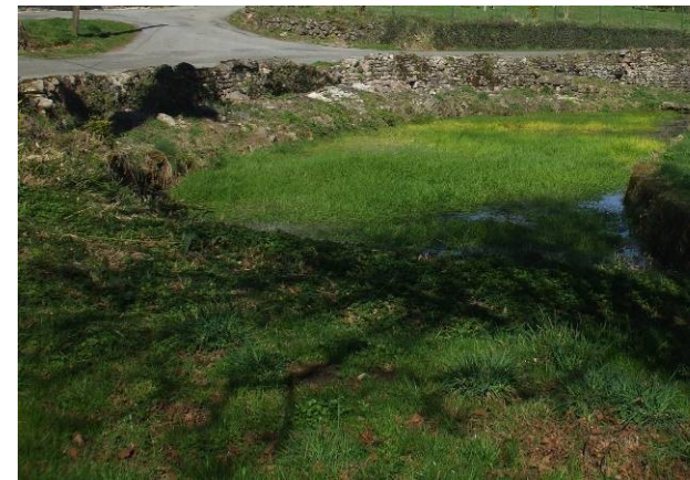
Réseau de murets et serve dans le village des Adoux.
