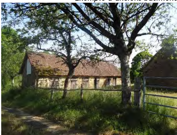
Sept fonds, ancien petit bâtiment agricole d'un corps de ferme.
