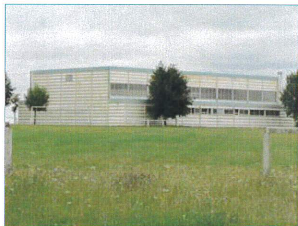
Gymnase près du complexe sportif
