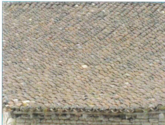
Toiture recouverte en tuile en « tige de botte ».
