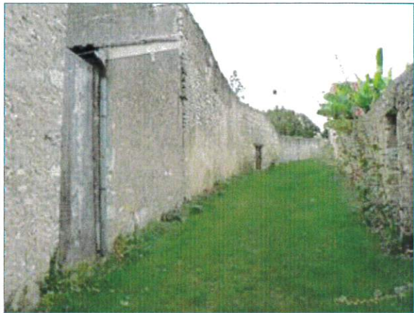
Constructions et murets en moellons calcaires
