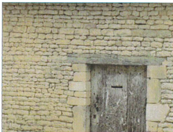
Mur en moellon calcaire rectangulaire.
