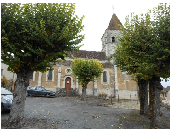
Espace public et Eglise
