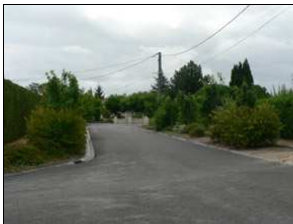
Lotissement des coutardières (années 1980) : opération d'ensemble bénéficiant d'un aménagement qualitatif des espaces publics (trottoirs et plantations).
