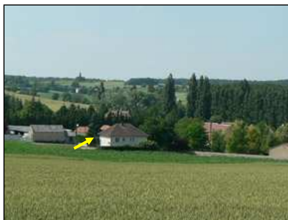
Passage d'une canalisation d'eaux pluviales
