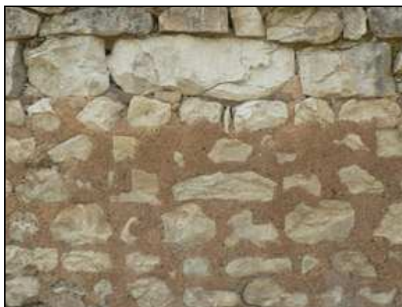
Mur en moellons calcaire et enduit sablé
