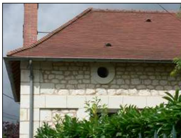
Toiture d'influence berrichonne, encadrements en pierre de taille et murs en moellons calcaire
