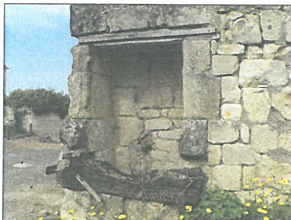
Puits d'aération d'une galerie sous une rue
