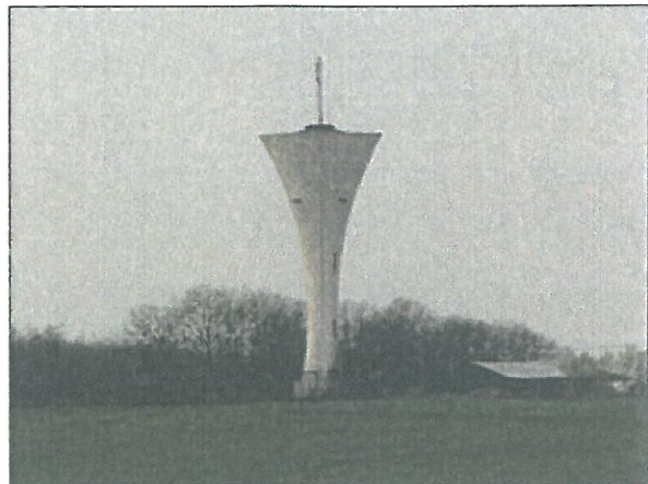
Le château d'eau. Visible de tout le territoire communal, il est un point de repère paysager important.
