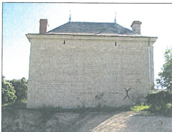
Pignon d'une maison d'habitation dans le village de Bessé
