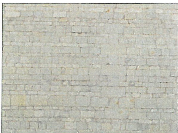
Mur en pierre de tuffeau taillée
