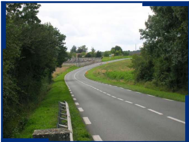
5 : "Le Grand Gué" : limite de zone inondable rive gauche au niveau de l'ombre dans le virage
