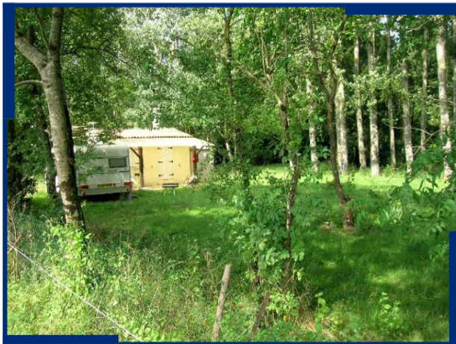
6 : "Les Buffrières" : maison en zone inondable
