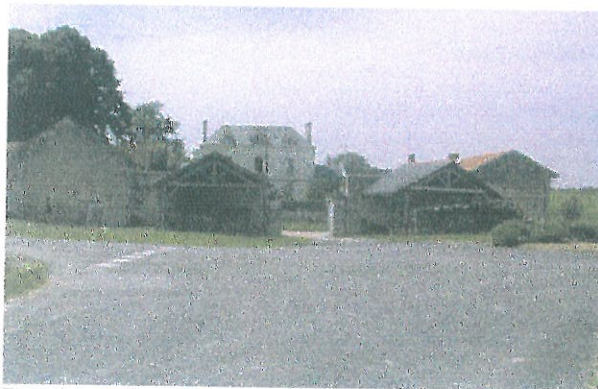
Beaulieu – toiture ardoise signant la maison de maître
