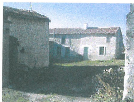
- Bâti ancien – présence de carrières
