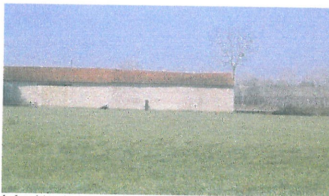
la Landrie – bâti de caractère.
