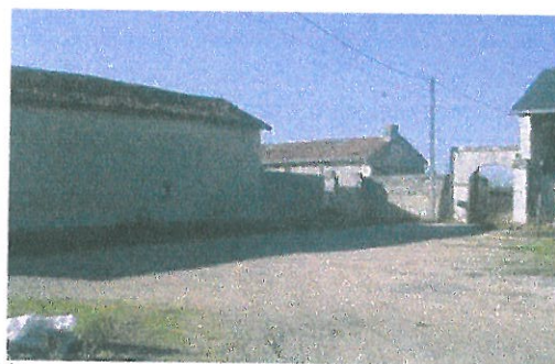
Bâtiment de ferme – porche
