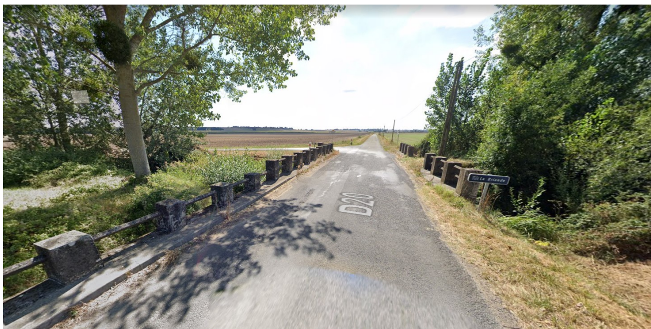
Figure 48. La Briande au Sud de la commune de Mouterre-Silly
