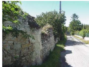
Le chemin rural « des murs »
