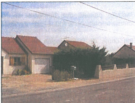
Constructions contemporaines en lotissement avec clôtures « urbaines » (mur et haie de Cupressus).
