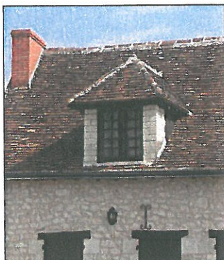
Lucarne sur le toit
