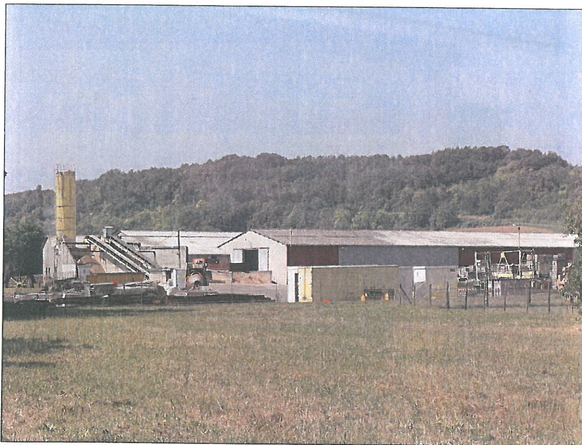
Entreprise de bâtiment et travaux publics au sud du bourg
