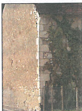
Chaînage en pierre de taille
