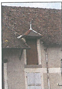
Lucarne entre mur et toiture
