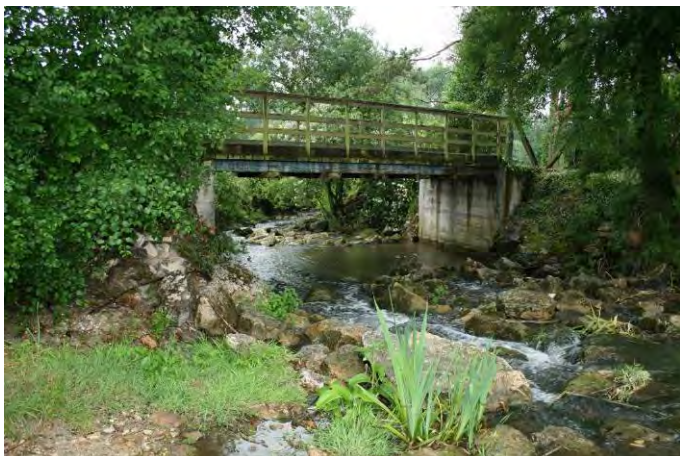
Figure 5bis : Vue du lit de la Luire
