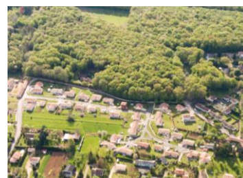
Ouest bourg : lisière boisée (domaine de Lépinoux) et « cordon végétal » devant la parcelle bâtie
