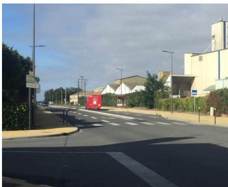
L'arrêt bus sur la RD 951, au droit de l'ancienne gare
