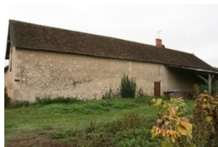
Les Charbonneries (P41), changement de destination
