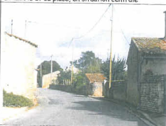
des trottoirs étroits, voir inexistants.
