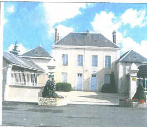
La mairie et sa place, en situation centrale
