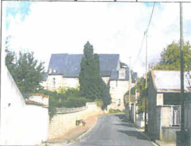
1542 Des constructions dans l'alignement de la voirie
