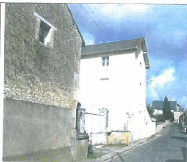
De l'ardoise sur des toitures à deux pans
