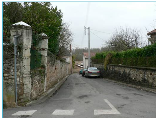
Rue étroite desservant les habitations du coteau
