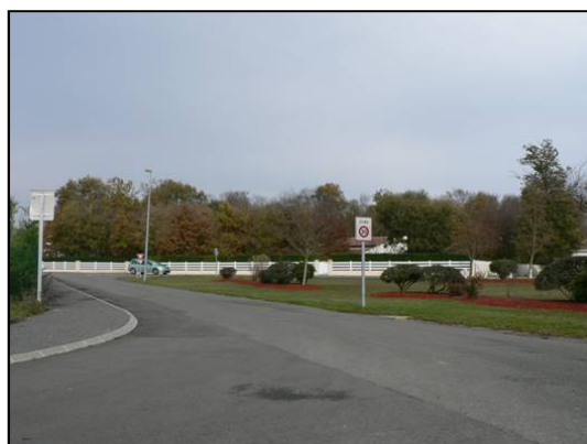
Aspect marquant dans le paysage bâti : impression de boisement par la conservation du bois en place lors de la construction
