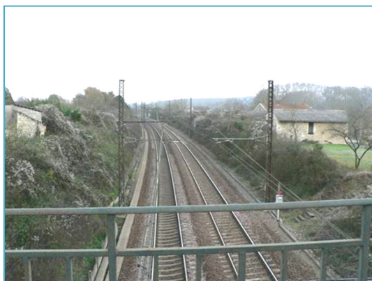
Ligne de chemin de fer : barrière entre les zones bâties de la commune
