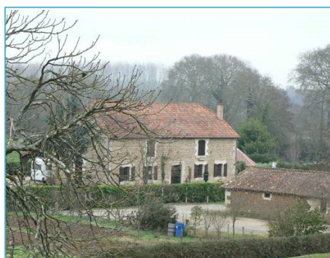
La ferme du pont
