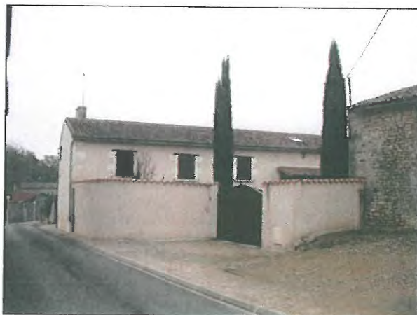
Réhabilitation dans le bourg
