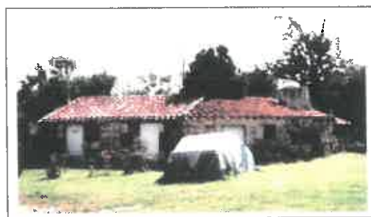
Bâti aux Basses Guillotières
