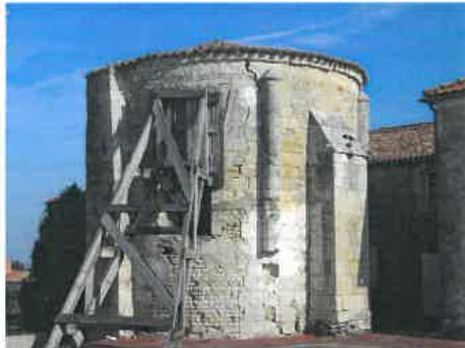
Photo 2 : L'ancienne église en cours de réhabilitation
