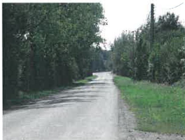
Voirie bordée d'arbres de haute tige dans la partie Sud de la commune, à la Bijétrie.
