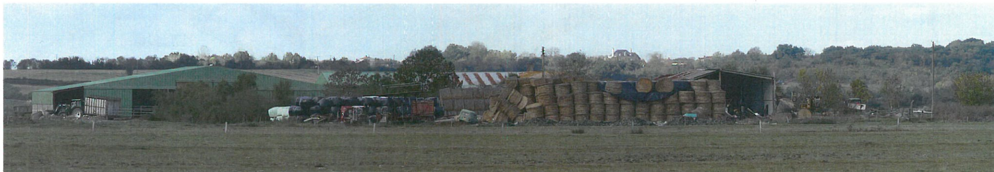
La façade Est du siège d'exploitation de la Joyeuse depuis la RD 127 (zoom)
