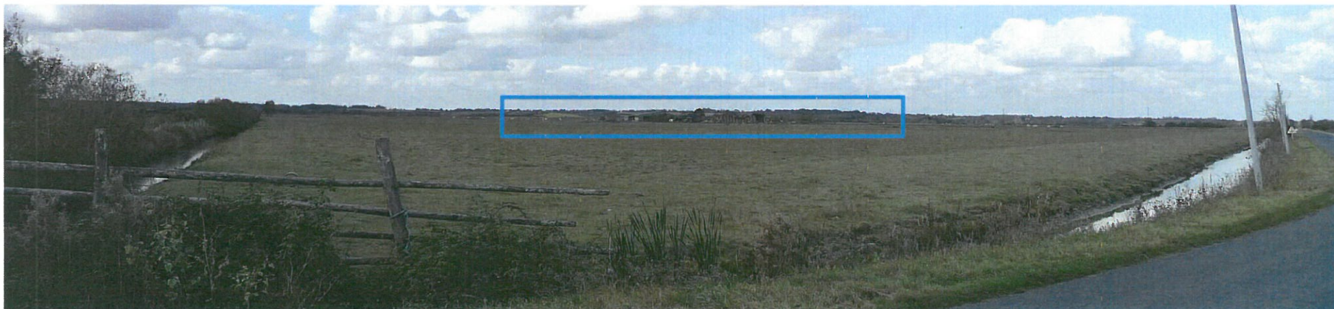
La façade Est du siège d'exploitation de la Joyeuse depuis la RD 127 (vue lointaine)
