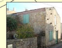
Maison de caractère en pierre
