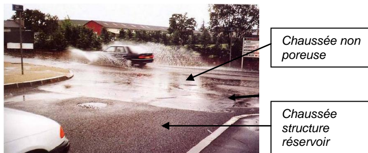
Chaussée à structure réservoir, Craponne (69)
