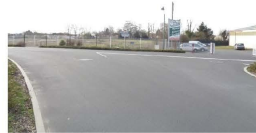
Figure 5 : Carrefour à sécuriser
