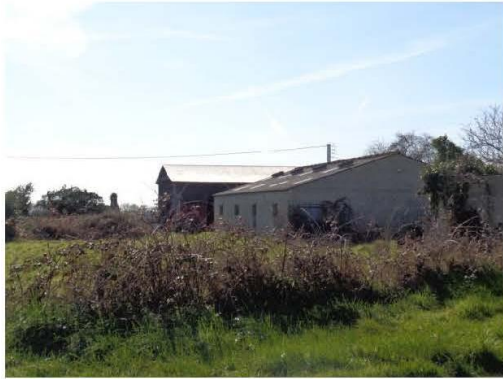
Figure 24 : Bâtiments à intégrer au périmètre de l'OAP
