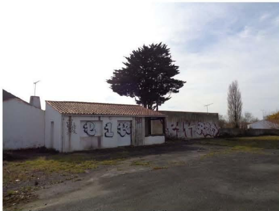
Figure 4 : Ruines existantes de l'ancienne entreprise
