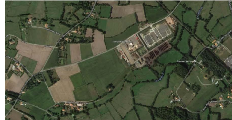
Figure 44 : vue aérienne du poste RTE
