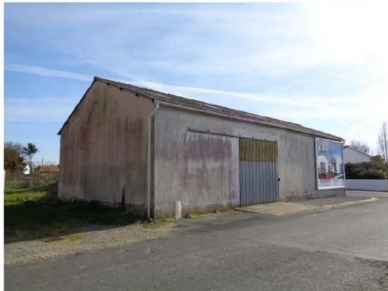
Figure 10 : Bâtiment à intégrer au périmètre de l'OAP
