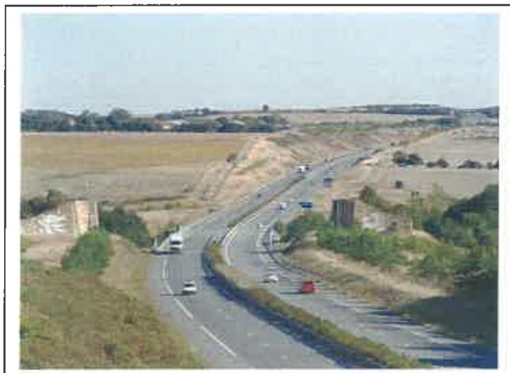
L'A83, une tranchée importante dans le paysage
