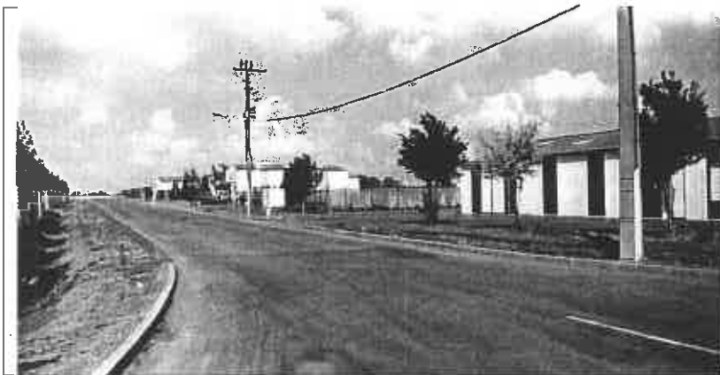
Route desservant l'entreprise THOINARD. vue vers la R.N.148
