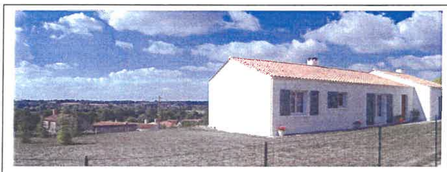
Extension récente sur les hauts de la Grenouillère
