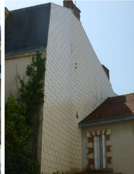
Ardoise fibres ciment (ciment et fibres minérales).
