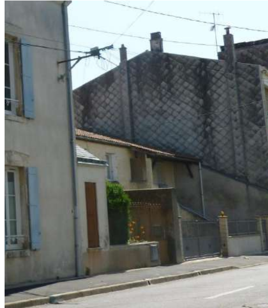
Ardoise d'amiante ciment
