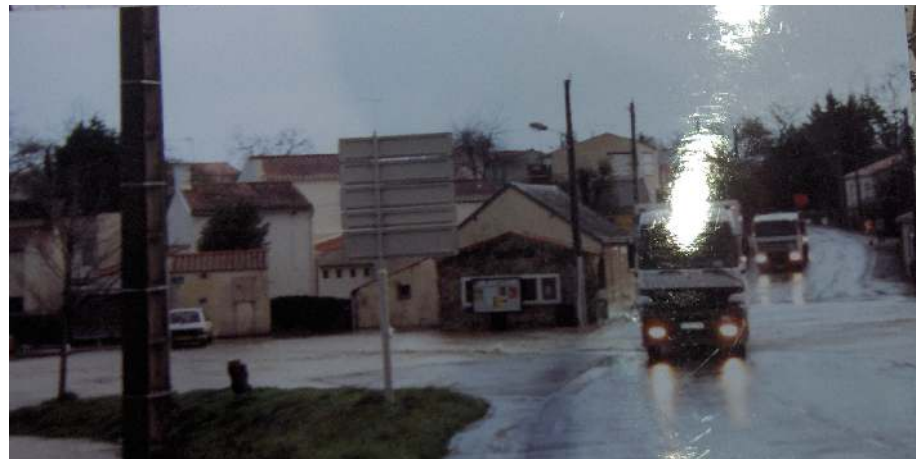
Photo 23: Crue du 8 décembre 2006 route coupée au lieu dit "les Essais"
