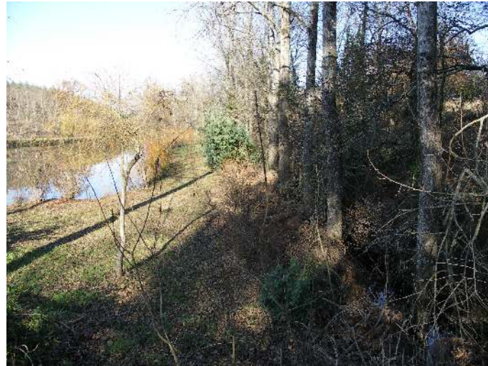
Photo 10: La Ciboule à proximité de sa source (RD36), étang en remblai dans le lit majeur
