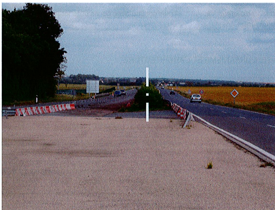
Une haie séparatrice de chaussée sur la première partie de la zone d'activité
