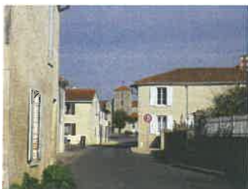
Gabarit restreint, bâti à l'alignement et en R+1 (rue du Cèdre)
