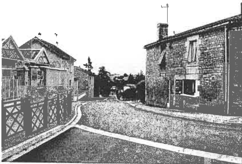
Rue belliard aménagée
