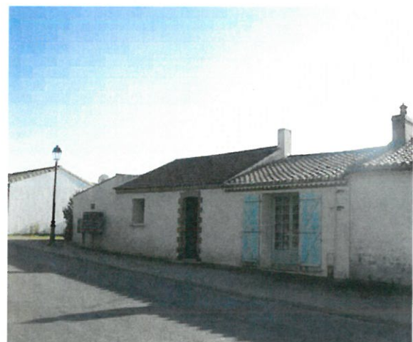
Façade typique du bocage vendéen : horizontalité des lignes, ponctuation contrastée des encadrements de briques apparentes et du bleu des menuiseries.
