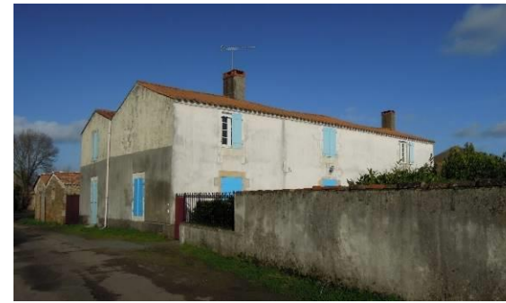
Maison rurale, rue de la Jaulnière
