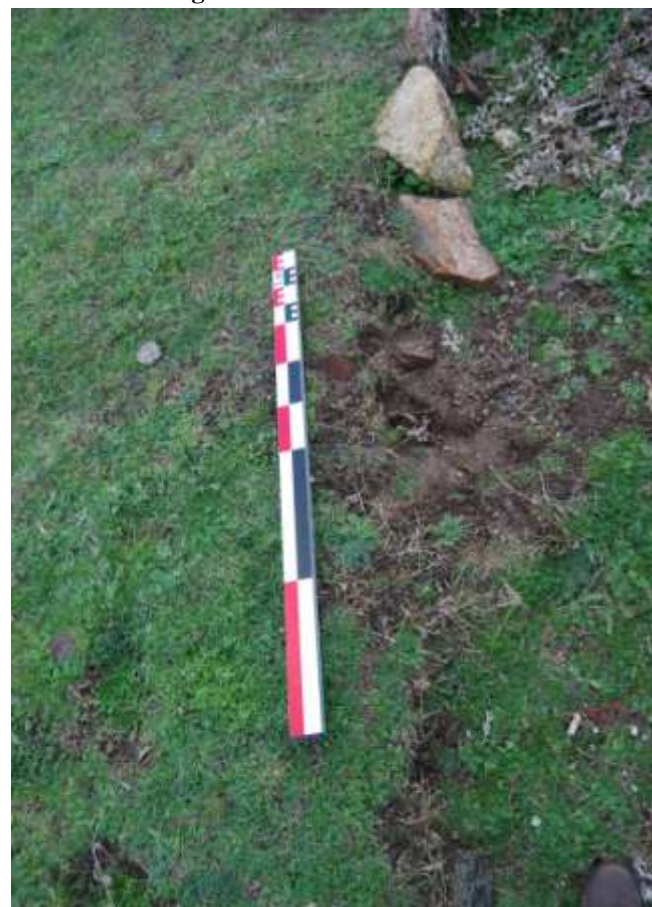
Figure 4 : détérioration de l'une des parois du four ouest. Descellement et disparition des pierres.
