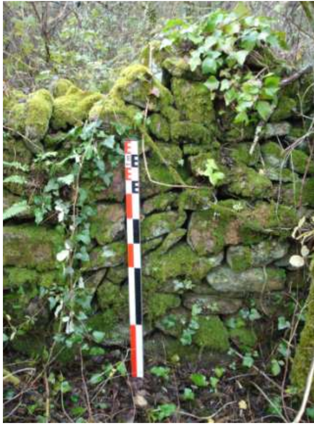
Figures 3 : vestiges de mur
